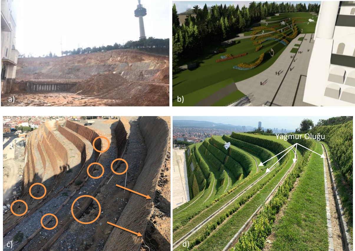
Şekil 1. Projenin Genel Görünümü: (a) Projeye Başlamadan Önceki Görünüm, (b) Proje Bittikten Sonra Hedeflenen Görünüm, (c) İklim Değişikliği Hasarı, (d) Yağmur Oluğu Çözümü
